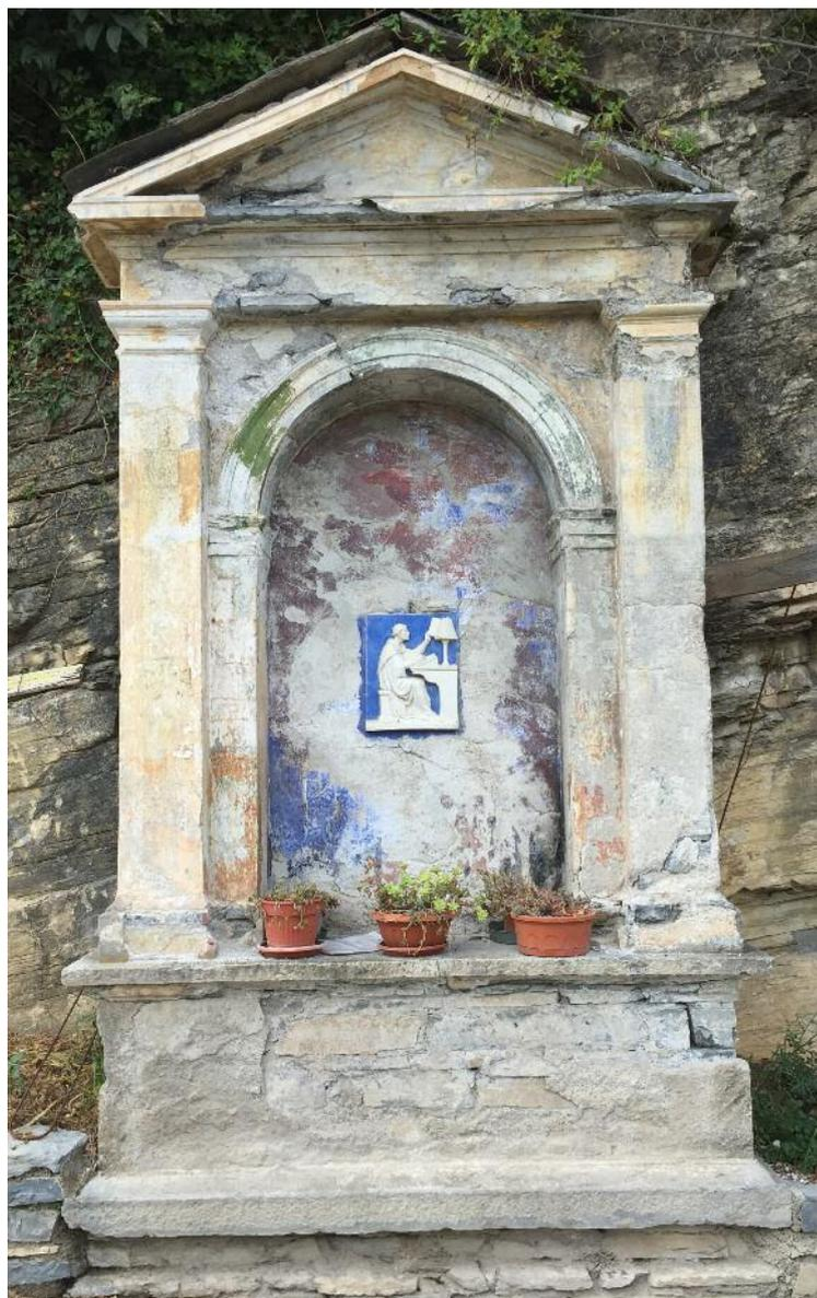
Il nucleo statico della struttura è formato da pietra di Moltrasio semi squadrata in blocchi e legata con malta. Lo stesso materiale, ma lavorato a spacco, è utilizzato per il piano di appoggio e la copertura.
